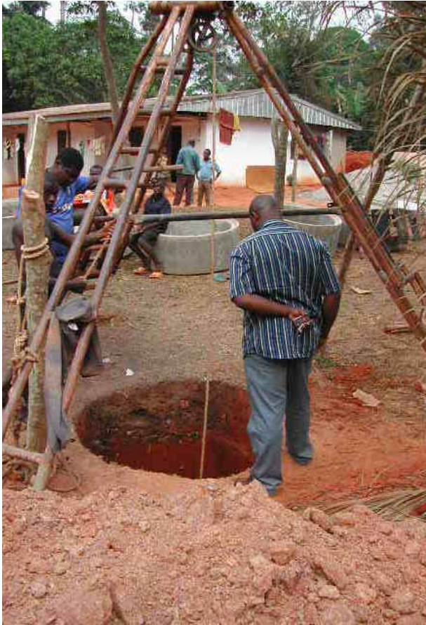
Mejora de las condiciones de vida de la población más vulnerable de Yaoundé, Camerún, mediante la construcción de un pozo
