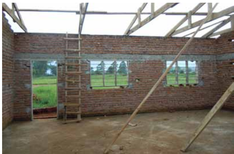
Construcción de aulas en el Colegio Padre Pío de Lusangazi, Malawi
